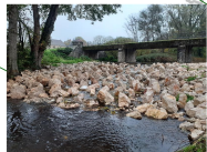
Restauration de la continuité sur deux seuils de la Clauge Syndicat mixte Doubs Loue Goux (39), 2020
