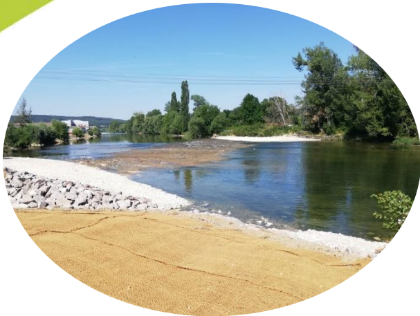
Pays de Montbéliard Agglomération et EPTB Saône et Doubs Seuil de Beaulieu effacé Mandeuire/Valentigney (25), 2019
