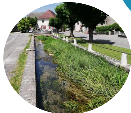
Pays de Montbéliard Agglomération et EPTB Saône et Doubs Restauration du Bié Colombier-Fontaine (25), 2018
