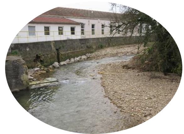
Ancien SIVU du Gland Arasement de plusieurs ouvrages sur le Gland Audincourt (25), 2017
