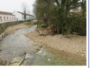
Arasement de 4 seuils sur le Gland Ancien SIVU du Gland Audincourt (25), 2017
