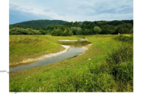
Aménagement d'annexes du Doubs EPTB Saône et Doubs / Pays Montbéliard agglomération Bart (25), 2020
