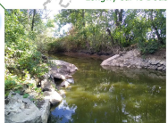
Aménagement de la Guyotte et arasement du seuil des Montots Syndicat mixte de la Guyotte Frontenard - Navilly (71), 2018
