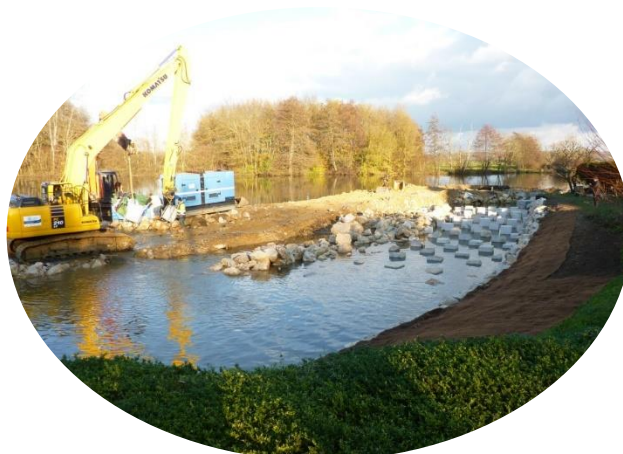
Voies navigables de France (VNF) Aménagement d'une passe à poissons Azans (39), 2015
