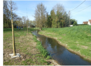
Restauration de la Sablonne et d'une zone humide Syndicat de la Sablonne Saint-Loup (39), 2016
