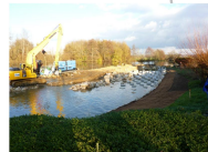
Aménagement d'une passe à poissons sur le Doubs Voies navigables de France (VNF) Azans (39), 2015
