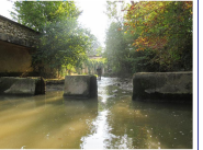
Arasement de 2 seuils sur le Gland Ancien SIVU du Gland Seloncourt (25), 2016
