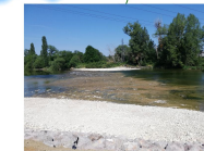
Effacement du seuil de Beaulieu sur le Doubs EPTB Saône et Doubs / Pays Montbéliard agglomération Valentigney (25), 2019
