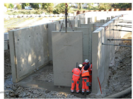
Aménagement d'une passe à poissons sur le Doubs Voies navigables de France (VNF) Orchamps (39), 2022
