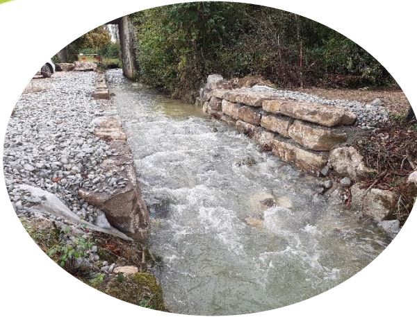
Syndicat mixte Doubs Loue Restauration de la continuité du seuil SNCF sur l'Orain Poligny (39), 2021
