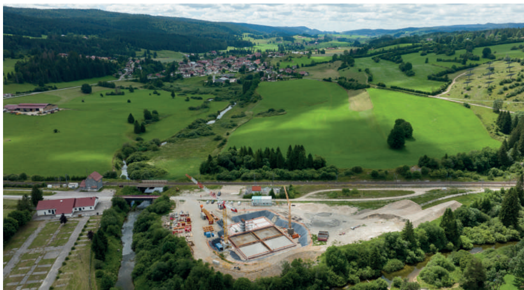
Construction d'une station d'épuration à Longevilles Mont d'Or
