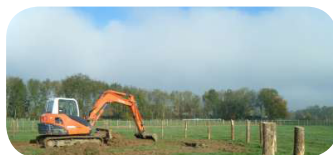
Création du nouveau tracé du ruisseau à la pelleteuse (source EPTB S&D).
