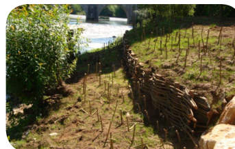
Renforcement de berge en aval du barrage Cussey-sur-l'Ognon (Source : SMAMBVO)
