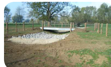
Stabilisation du profil en long à Jallerange (Source : SMAMBVO)
