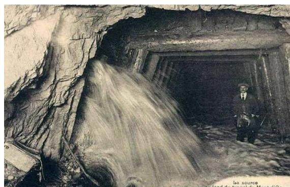
Figure 11- Photographie d'époque de la venue d'eau lors du creusement du tunnel (source : arnexehistoire.blogspot.com 2013)
