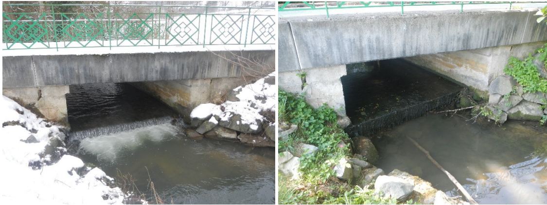
La Ranceuse, ouvrage de la route D337, en eau moyenne et en étiage
